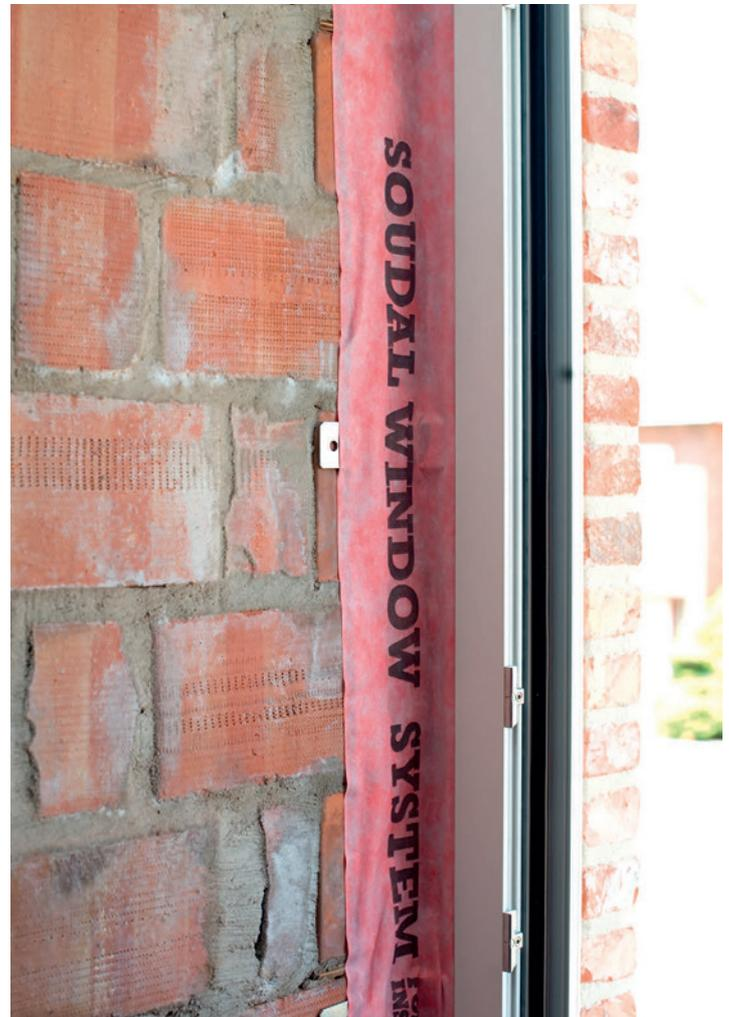
El EPDM es un producto impermeable al agua, pero con una cierta permeabilidad al vapor, lo que permite que el edificio transpire mientras asegura la estanqueidad al viento y al agua de las fachadas. Gracias a su flexibilidad, la colocación en obra es muy fácil. La fijación puede ser por anclaje mecánico o mediante un adhesivo/sellador específico para EPDM.
